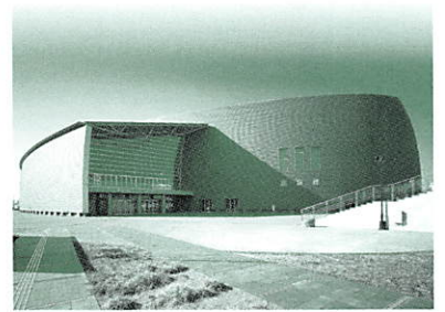
名称：なら100年会館 所在地：奈良市三榮空町7番1号 開館：平成11年2月1日 設計：磯崎 新 アトリエ 敷地面積：16,061m 2 建設面積：6,416m 2 延床面積：22,682m 2 階層：地下1階、地上5階 構造：鉄筋コンクリート造・ 鉄骨鉄筋コンクリート造・ 鉄骨造
